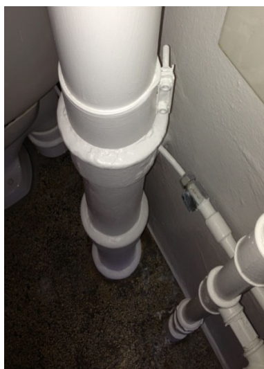
Reparation på faldstamme
