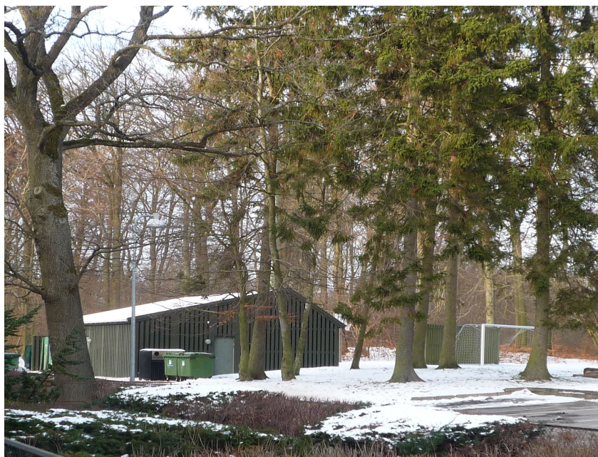
Tidl. Varmeværk, som ombygges til fælleshus
